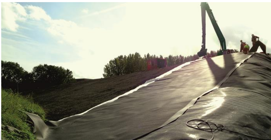
Foto: overzicht aanleggen IBC werk.
